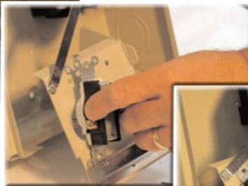
SE ABREN LOS ORIFICIOS SEMIPERFORADOS Y LOS DISPOSITIVOS DE CABLEADO SE DEJAN CAER EN SU LUGAR.
