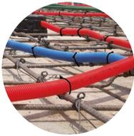
Los cinchos sujetan la tubería a la malla de la losa sin deformar el diámetro interior.
