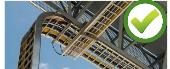
Elegir correctamente el Peralte y Ancho de Charola depende del conductor a utilizar ,la clasificación de carga deseada y usar como referencia las normas
