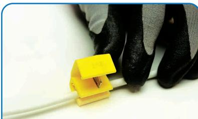
Coloca el Conector Derivador Scotchlok® IDC sobre el cable energizado.
